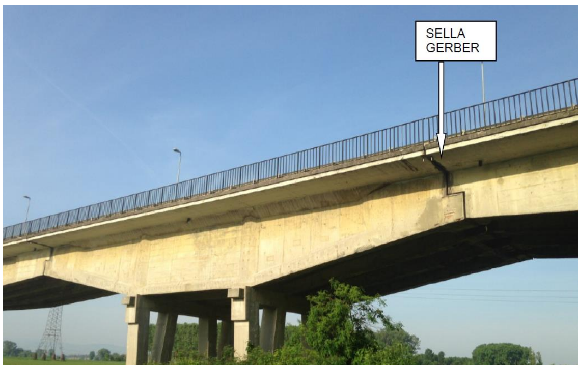
Figura 3 – Particolare selle Gerber
